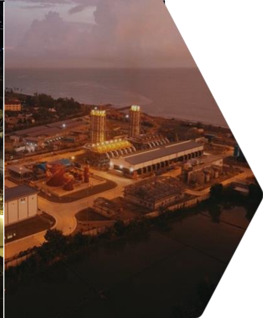
PT PLN Lombok / 135 MW
